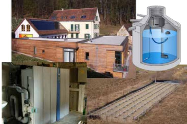
Wohnanlage in Pöllau bei Gleisdorf mit Regenwassertank, Grauwasseraufbereitung und Pflanzenkläranlage
